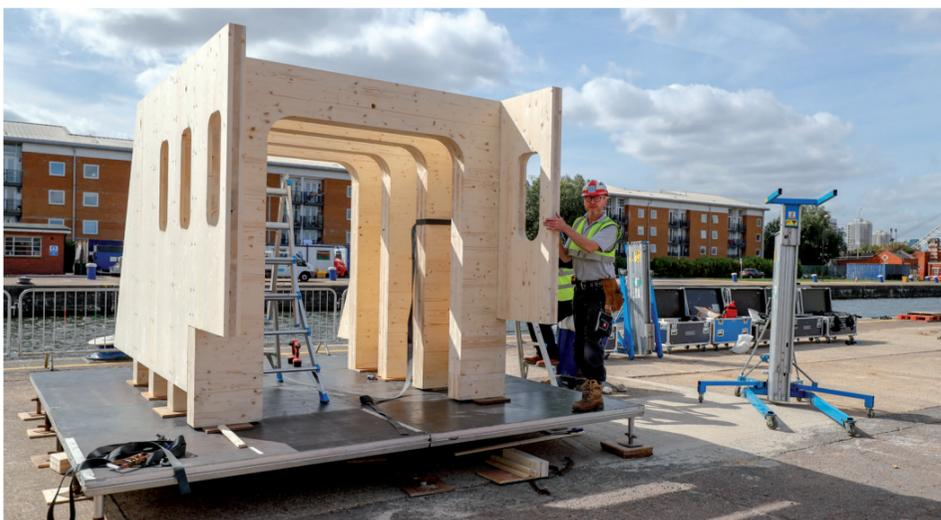
und die Nähe des Flusses griffen das Holz von der ersten Minute an. Für den entsprechenden Schutz vertraute das verarbeitende Unternehmen Unusual Rigging Ltd. aus Northamptonshire auf Induline GW-310 farblos von Remmers. Die wasserbasierte Beschichtung mit Bläueschutz für Holz im Außenbereich kann bei maßhaltigen Bauteilen als Grundierung eingesetzt werden, bei begrenzt und nicht maßhaltigen Bauteilen sowohl als Grund-, Zwischen- und Schlussbeschichtung.
